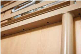
Bohrungen in den Metallprofilen lassen Restflüssigkeit abfließen.
